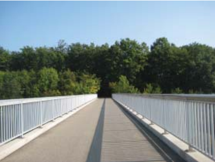
Passerelle de l'autoroute
