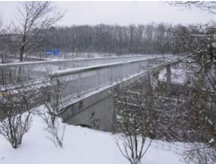
Passerelle de l'autoroute
