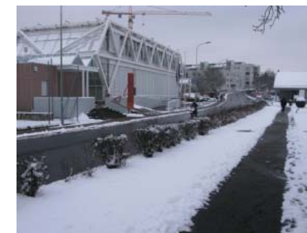
Centre sportif du bois des frères
