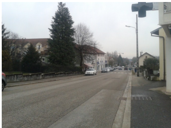
Saint Genis Pouilly, tronçon n° 258
