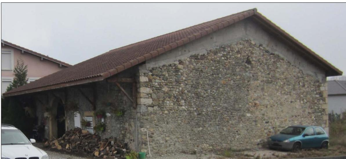
Ferme genevoise avec des murs en boulets et une pente de toit correspondant à une couverture en tuiles creuses (Versonnex)
