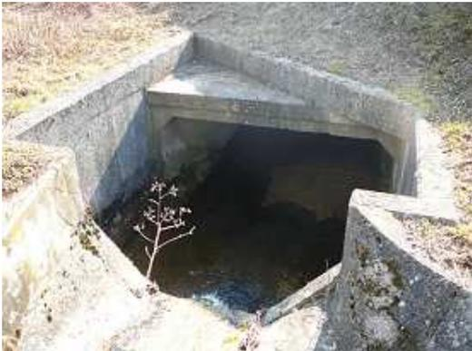
Les "passages à faune" existants sous les routes sont souvent non fonctionnels. Exemple d'une buse bétonnée sous la 2x2 voies.
