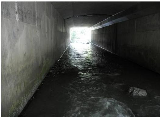
L'ouvrage hydraulique sous l'A40, pour le passage du Bronze, ne dispose pas de banquettes pieds secs (crédit photo : C. Gilles).
