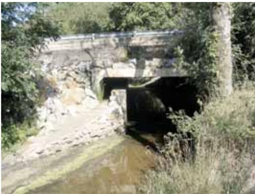
Banquette dans un ouvrage hydraulique, en Loire-Atlantique, permettant le passage de la Loutre et, plus généralement, de la petite et moyenne faune (renards, blaireaux, rongeurs...).
